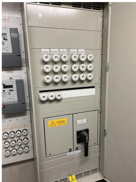
Figur 7. Elcentral för Hus B på bottenplan.
