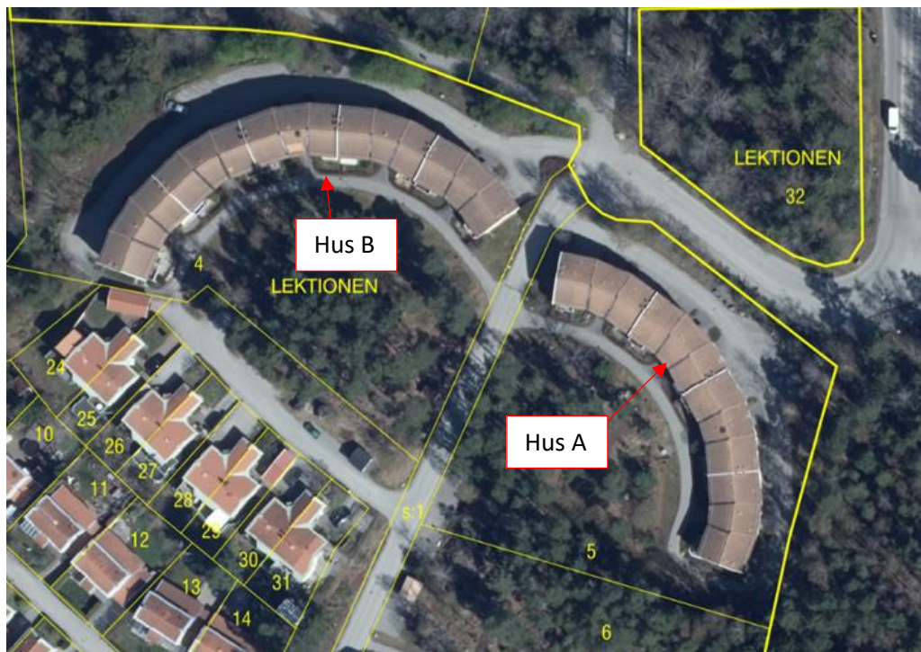
Figur 1: Flygbild över taken på de aktuella byggnaderna.
