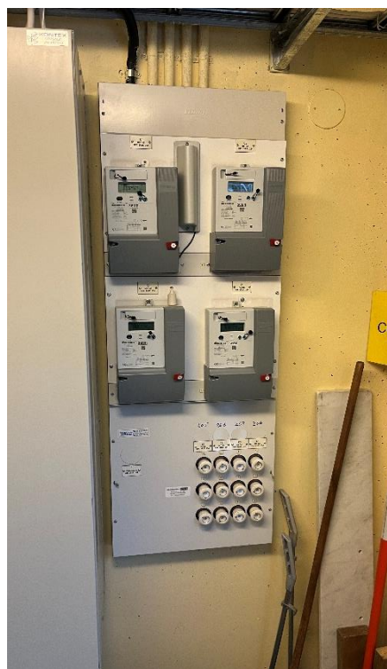
Figur 1. Exempel på elmätare till lägenheterna förlagda till utrymmen i källaren i respektive trappuppgång.
