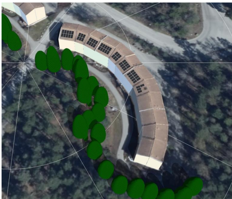
Figur 6: Exempel på solcellsanläggning Hus B
