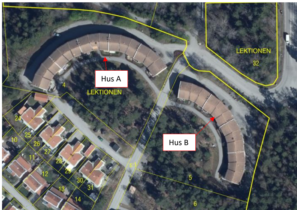
Figur 1: Flygbild över taken på de aktuella byggnaderna.
