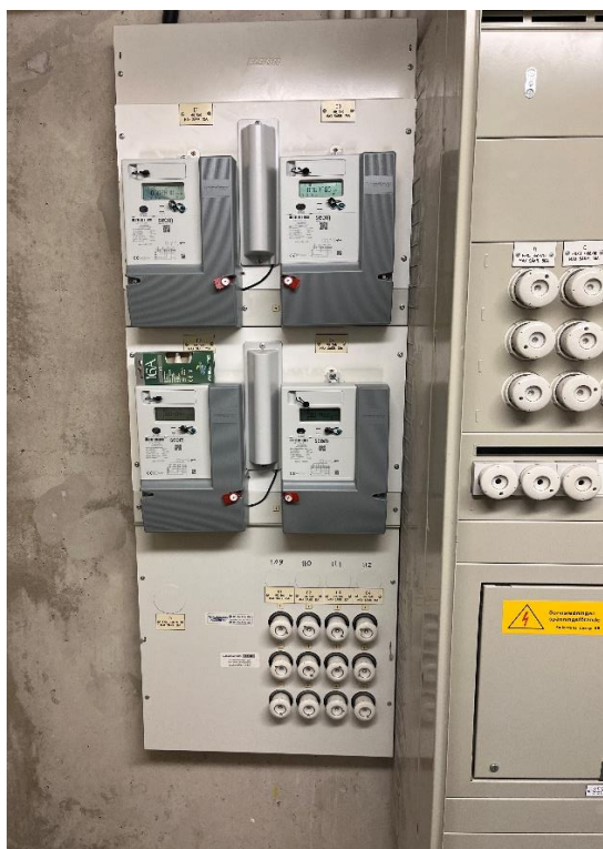
Figur 1. Exempel på elmätare till lägenheterna förlagda till utrymmen i källaren i respektive trappuppgång.
